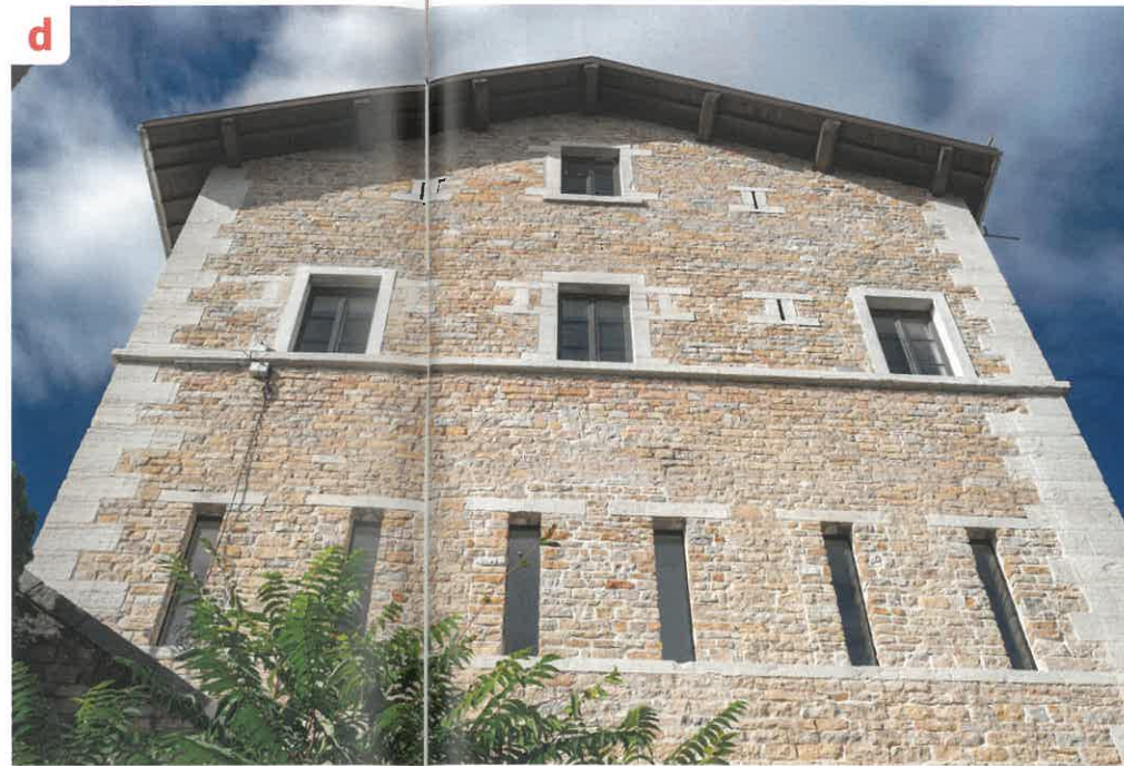
d/ Meurtrières - Côté est, les fines meurtrières du rez-de-chaussée ont été élargies pour devenir des lucarnes allongées, offrant aux clients des vues sur le Rhône. On retrouve quelques meurtrières d'origine au-dessus. L'architecte des Bâtiments de France a avaisé cette proposition. Ce ne sera pas la première fois que des ouvertures sont faites sur le bâti ancien. À l'origine, les pignons étaient dépourvus de fenêtres...
